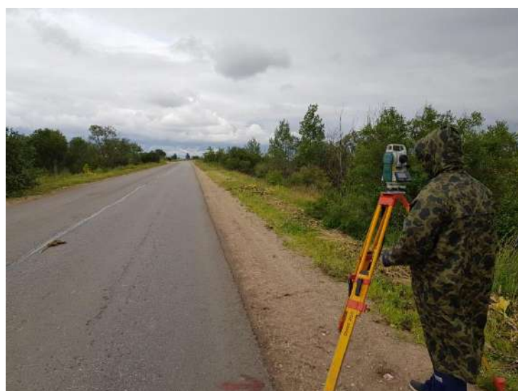
Производство тахеометрической съемки
