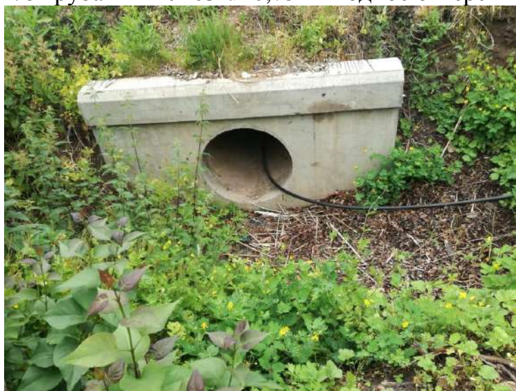
ж/б труба ПК 20+03 d=0,75 выходное отверстие
