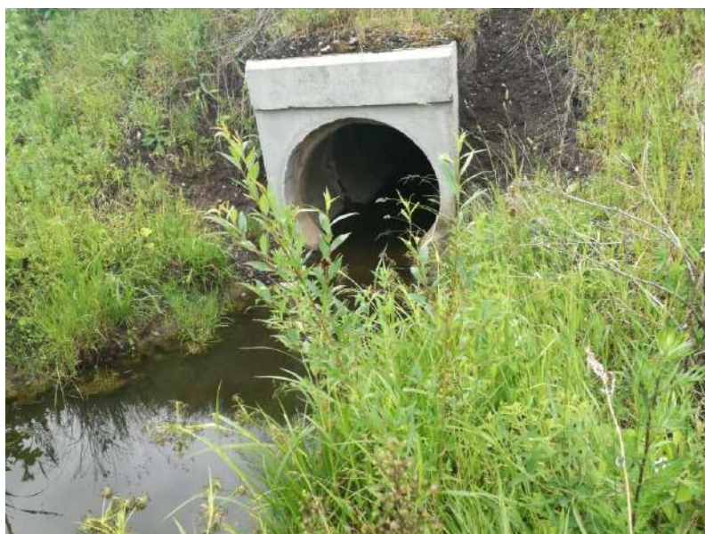
ж/б труба ПК 3+41 d=1.50 выходное отверстие
