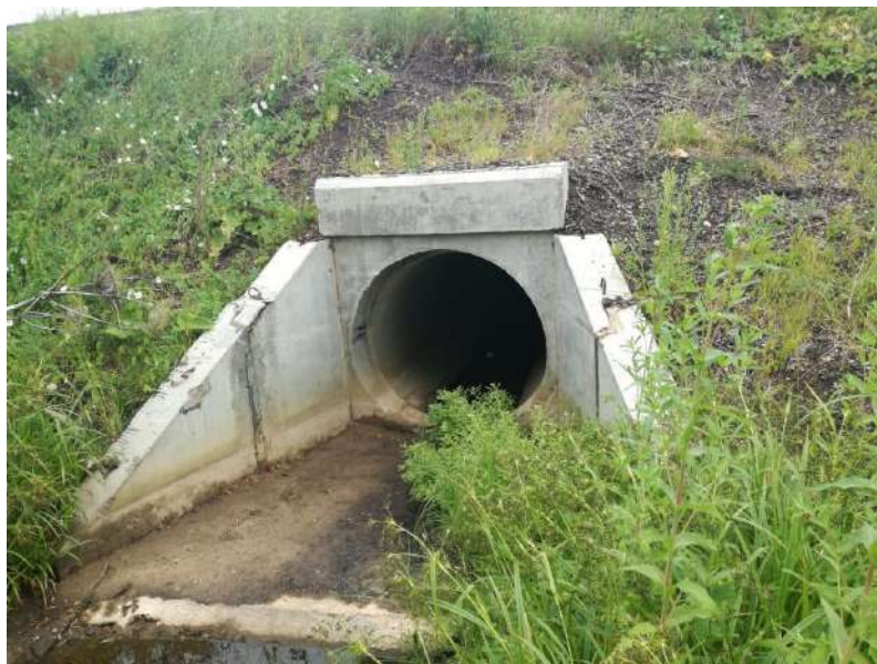
ж/б труба ПК 3+41 d=1.50 входное отверстие
