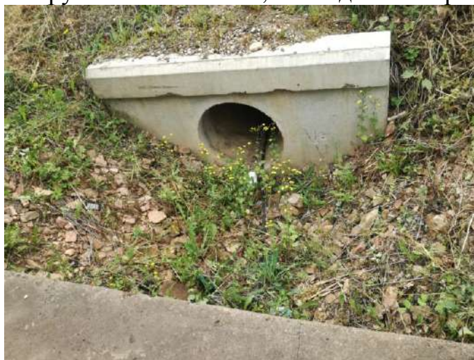
ж/б труба ПК 20+03 d=0,75 входное отверстие
