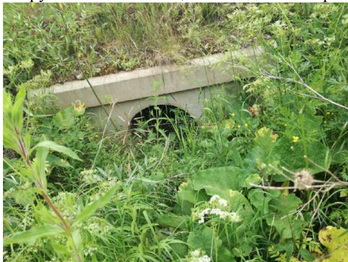
ж/б труба ПК 34+10 d=0,75 выходное отверстие
