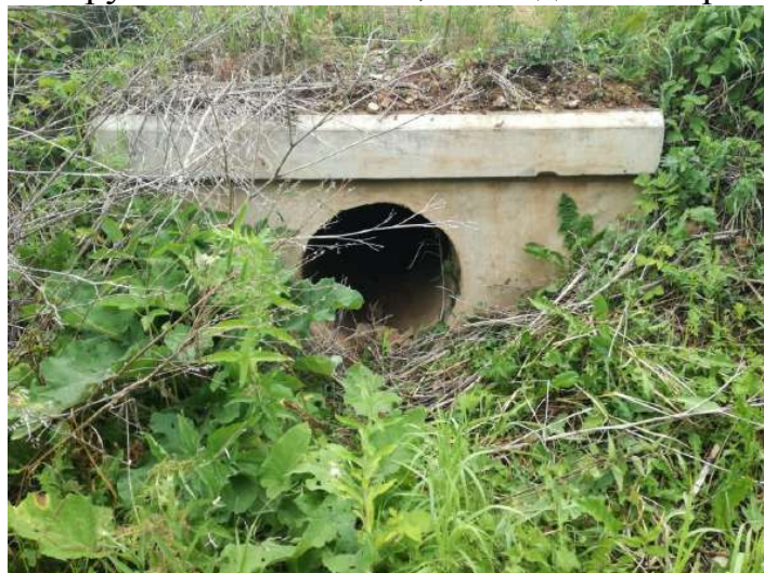
ж/б труба ПК 34+10 d=0,75 входное отверстие
