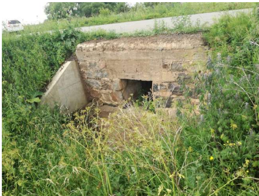
ж/б труба ПК 49+13 d=1,0*0,90 выходное отверстие
